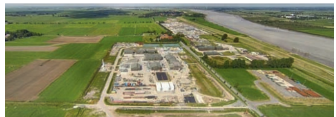
Der Landverbrauch des Kavernengebiets hat erschreckende Ausmaße angenommen, so dass die Jemgumer von vielen Besuchern bedauert werden. Foto: EWE GASSPEICHER.
