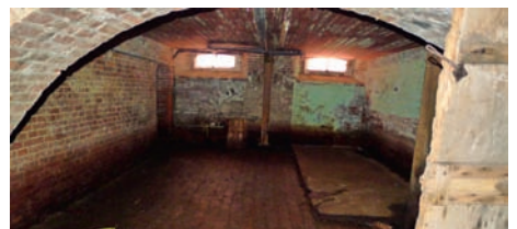
Blick in die Kellerräume des Gasthauses. Fotos: G. Kronsweide
