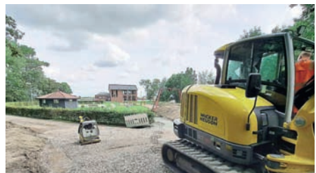
Geländeerhöhung gegen Überschwemmungen. Foto: H. Szyska, RZ 2.9.2023.
