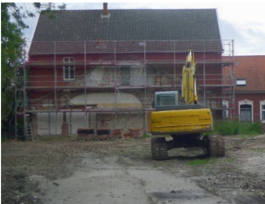
Rückansicht im September nach dem Abbruch. Foto: Kronsweide
