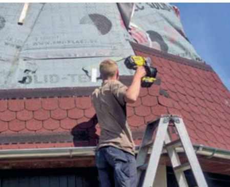
Ein Mitarbeiter im Einsatz bei fachmännischen Dacharbeiten. Fotos: Sonderseite der Rheiderland Zeitung zum Jubiläum.
